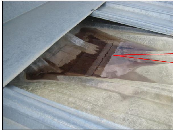
Placa de poliéster abollada
