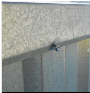
Tornillo perdido y restos de junta de EPDM/sellados degradado
